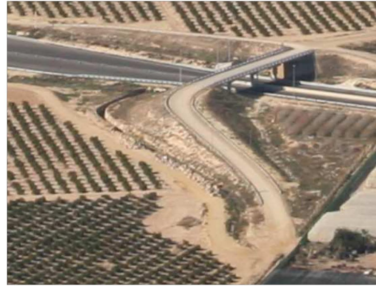
FOTO 1. Vista aérea del encauzamiento.
